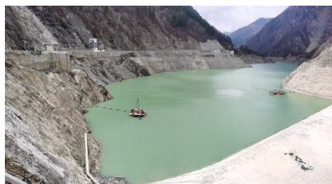
图1 水下检查孔施工条件
